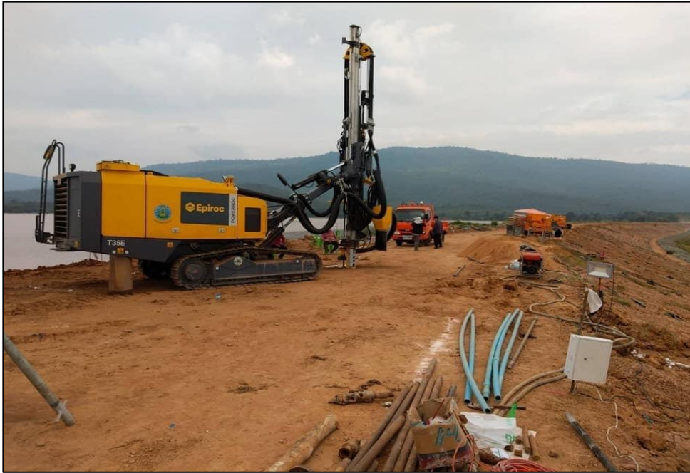
รูปที่ 3-18 เจาะเพื่อหาแนวรูรั่วของน้ำโดยใช้เครื่องเจาะแบบกระแทก
