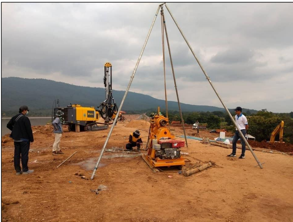
รูปที่ 3-19 เจาะเพื่อหาแนวรูรั่วของน้ำโดยใช้เครื่องเจาะแบบหมุน
