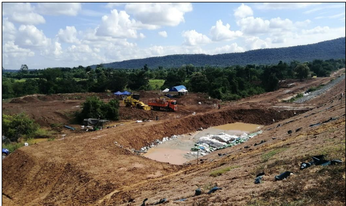
รูปที่ 3-8 การก่อสร้างบ่อเพื่อเพิ่มความสูงของระดับน้ำสำหรับลดแรงดันและความเร็วในการไหลของน้ำ
