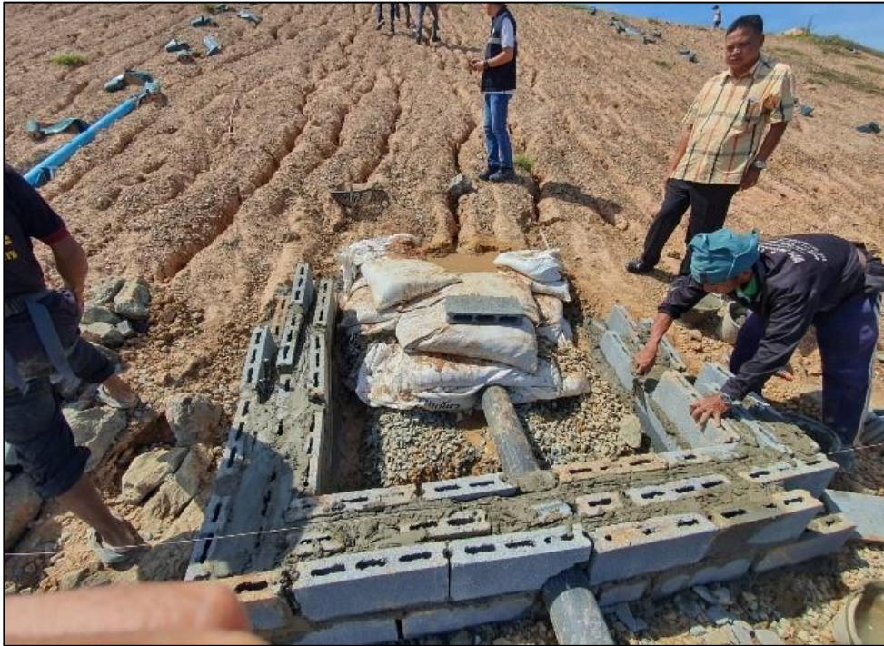
รูปที่ 3-5 การก่อสร้างป้อล้อมจุดที่น้ำไหลรั่วออกมาเพื่อวัดอัตราการไหลรั่วของน้ำ
