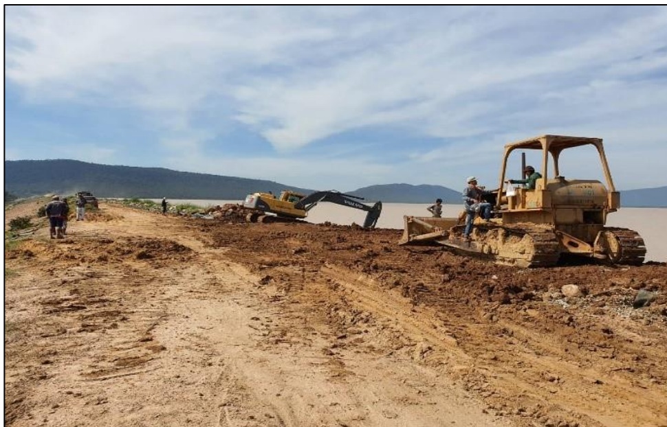
รูปที่ 3-10 การถมดินเสริมบริเวณลาดเขื่อนด้านเหนือน้ำ
