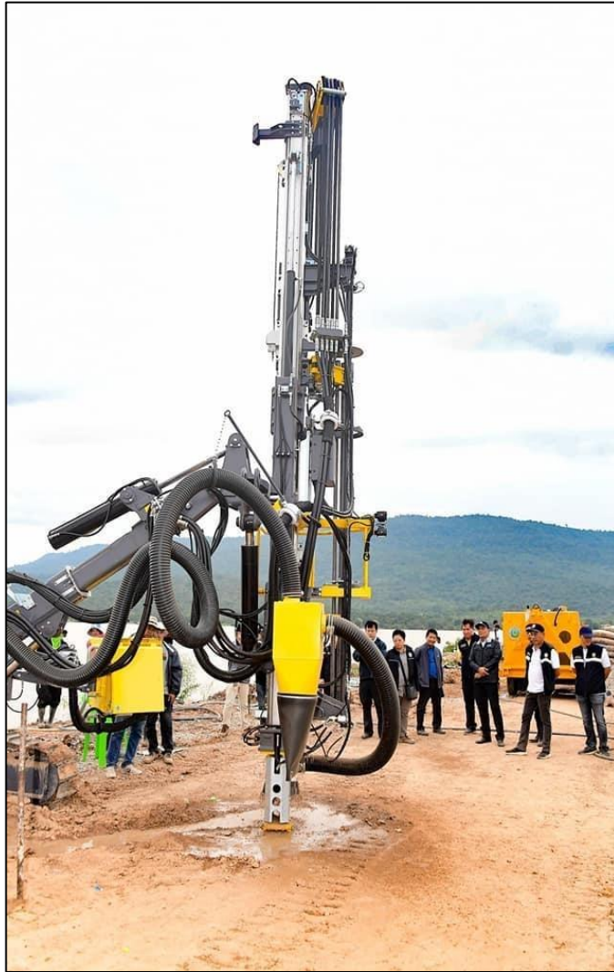
รูปที่ 3-22 จุดที่เจาะสำรวจพบการไหลร่วนของน้ำที่ตำแหน่ง กม.2+182 ที่ระดับประมาณ +98.50 เมตร (รสม.)
