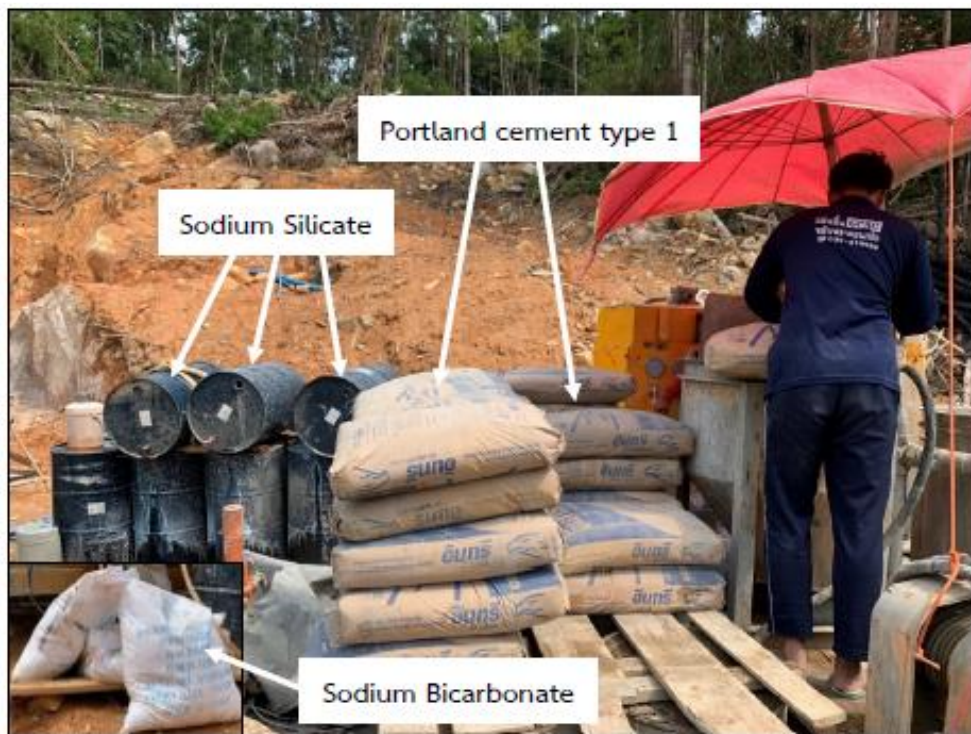
รูปที่ 3-16 แสดงวัสดุโซเดียมซิลิเกต โซเดียมไบคาร์บอเนต และปูนซีเมนต์ปอร์ตแลนด์ ประเภท 1
