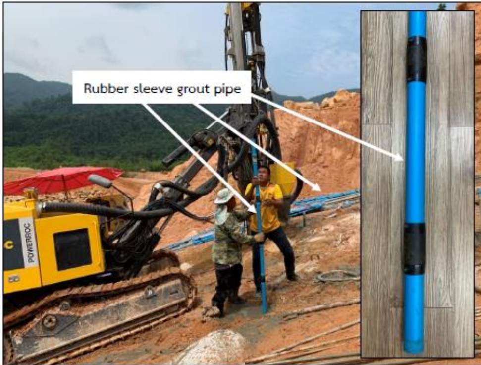
รูปที่ 3-15 แสดงวัสดุอุปกรณ์ชุดท่ออัดฉีดของผสมติดปลอกลูกยาง
