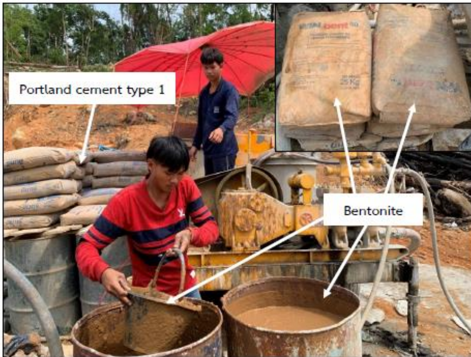
รูปที่ 3-17 แสดงวัสดุเบนโทไนท์ และปูนซีเมนต์พอร์ตแลนด์ ประเภท 1
